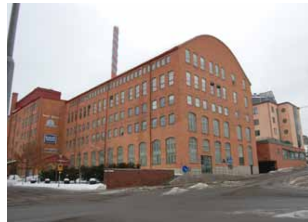
Före detta järngjuteribyggnad från 1916 som tillhört J V Svensons motorfabrik. Byggnaden om- och påbyggdes 1942. Huset tillhör områdets entrémiljö vid norra tunnelmynningen.
