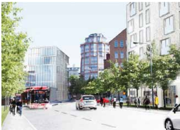
Vy från tunnelmynningen.
