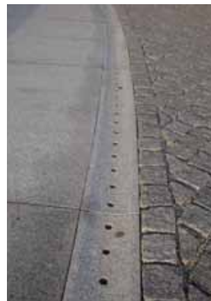
Exempel på dagvattenränna för ytlig avledning
