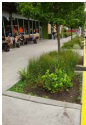
Exempel på infiltrationsyta i gaturummet.
